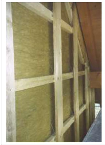
2002 Prinzip einer „Fassaden-Hängeschalung“ zur wärmebrückenarmen Befestigung hinterlüfteter Fassadenverkleidungen, z.B. Holzschalungen. Diese Befestigungstechnik ersetzt die üblichen, Wärmebrücken verursachenden Lattenroste (weil diese ja in der Dämmschicht liegen und dadurch viele Trennflächen samt Verarbeitungsfehlern in der Dämmschicht verursachen).
